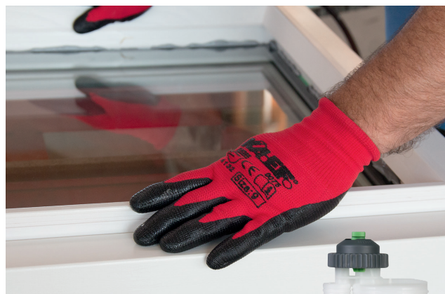
Handmatig aanbrengen van OTTOCOLL® S81 met een BlueLine-koker
