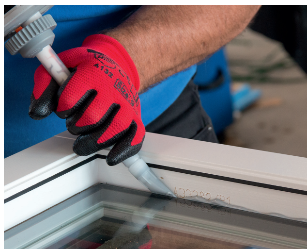
Handmatig aanbrengen van OTTOCOLL® S81 met een BlueLine-koker
