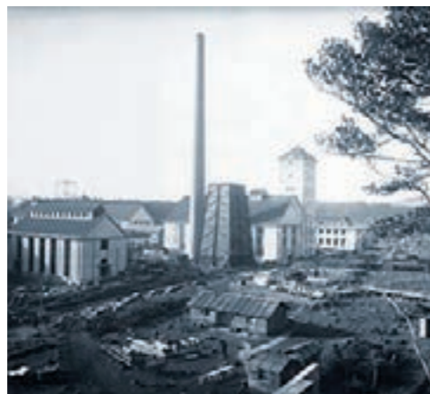
Das Wacker-Werk in Burghausen wird errichtet (1916).
