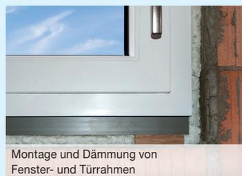
Montage und Dämmung von Fenster- und Türrahmen
