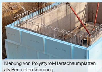
Klebung von Polystyrol-Hartschaumplatten als Perimeterdämmung
