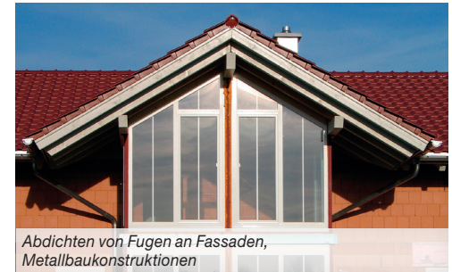
Hochbaufugen nach DIN 18540-F
