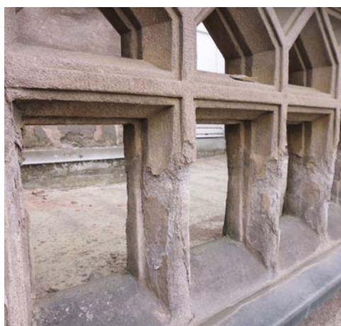
DIE SANIERUNG EINER SANDSTEINFASSADE AM DÜSSELDORFER RHEINUFER.
